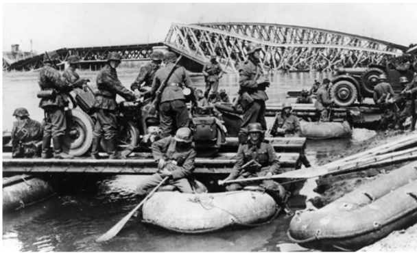
Overzetten met een 8-10 tons vlotveer 10 mei 1940 bij Westervoort (www.westervoort1940, foto nr 104). Beeldbank NIMH.
